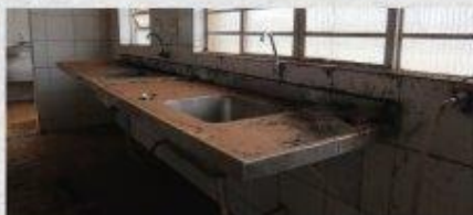
Cozinha do refeitório
